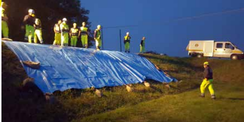
a sinistra si srotola il telone sull'argine per evitare infiltrazioni d'acqua nel terreno sotto volontari impegnati nel supporto logistico
